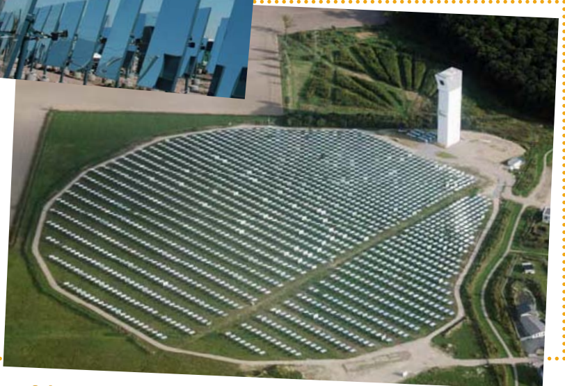
Solarturmkraftwerk zur Stromerzeugung in Jülich, Deutschland
