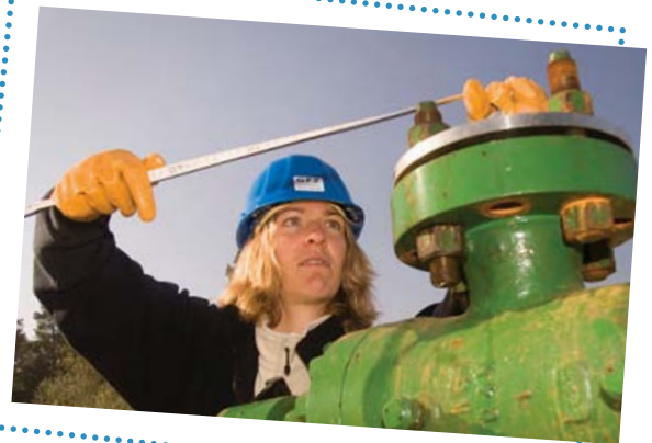
Technikerin überprüft Ventil (Geothermiebohrung)
