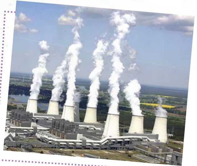
Kohlekraftwerk zur Erzeugung von Strom
